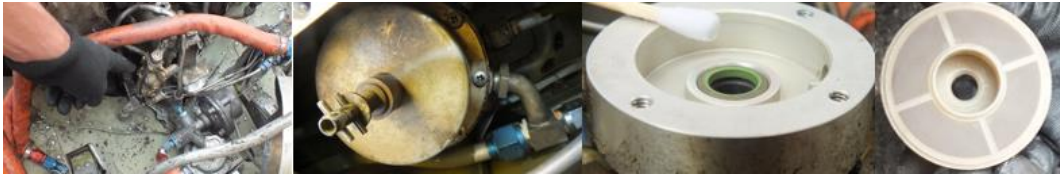
Graficas de las líneas, bomba, distribuidor y filtro del sistema de combustible de la aeronave HK4990
